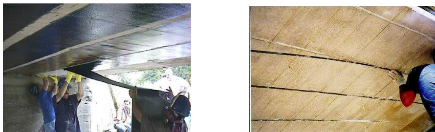
Slika 7. Povećanje nosivosti AB elemenata opterećenih na savijanje [4]
