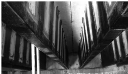
Slika 2. Ojačavanje AB greda na savijanje i smicanje [5]
